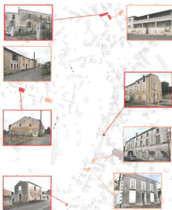
Localisation des logements dégradés sur la commune (Etude OPAH « habitat et développement- 2014)
